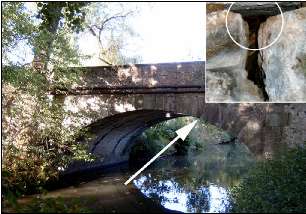
Abbildung 8: Wasserfledermausquartier in einer Mauerspalte auf der Unterseite einer Bachbrücke bei Gießen. Am 13.9.2003 wurden in diesem Quartier 21 Wasserfledermäuse (6 adulte Männchen und 15 Jungtiere) durch Fang nachgewiesen (siehe auch Abbildung 10). Am 31.08.2004 konnte dort eine potentielle Paarungsgesellschaft mit 7 Individuen (1 adultes Männchen, 3 adulte Weibchen und 3 Jungtiere) abgefangen werden (siehe Kapitel 5.7.) (aus Encarnação et al. 2005b).
