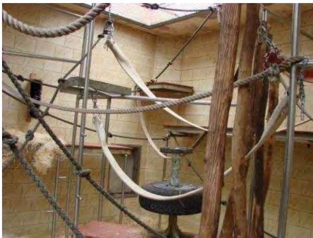
Abb. 89: Montierte Schläuche in der Bonoboanlage.
