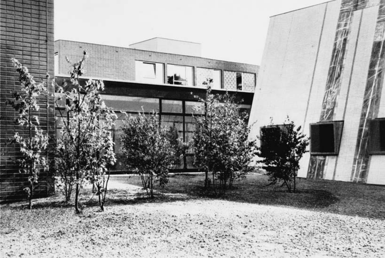
Die Leihstelle zwischen Bücherturm und Lesesaal. Dahinter das Verwaltungsgebäude. (Werkfoto Leitz)
