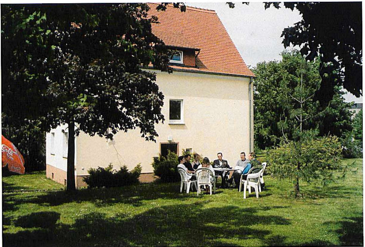
Das gemeindenahere teilstationäre Behandlungszentrum der Gießener Universitätspsychiatrie ist in einem normalen Wohnhaus untergebracht und liegt in einem Wohngebiet.
