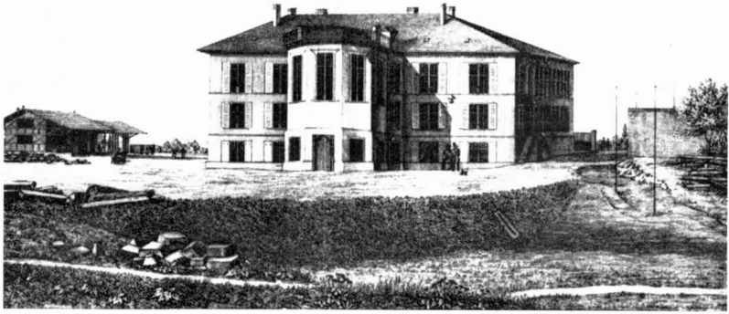
Abb. 1: Ansicht des Anatomiegebäudes von der Süd-West-Seite
