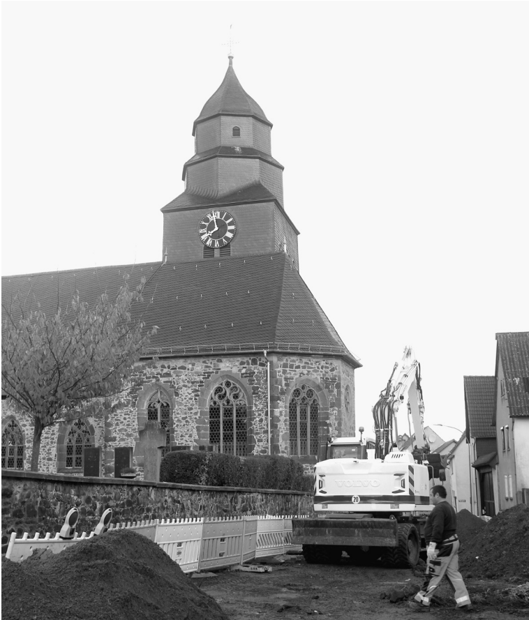
Abb. 2: Pohlheim-Grünigen. Die Stadtkirche von Süden während der Bauarbeiten (Foto: hessenArchäologie des LfDH)
