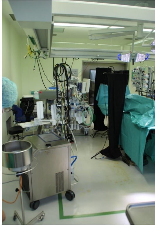
Abbildung 31: Anordnung der HCU in Raumklasse 1a
