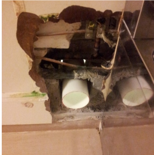
Abbildung 42: Ausführung des notwendigen Wanddurchbruchs
