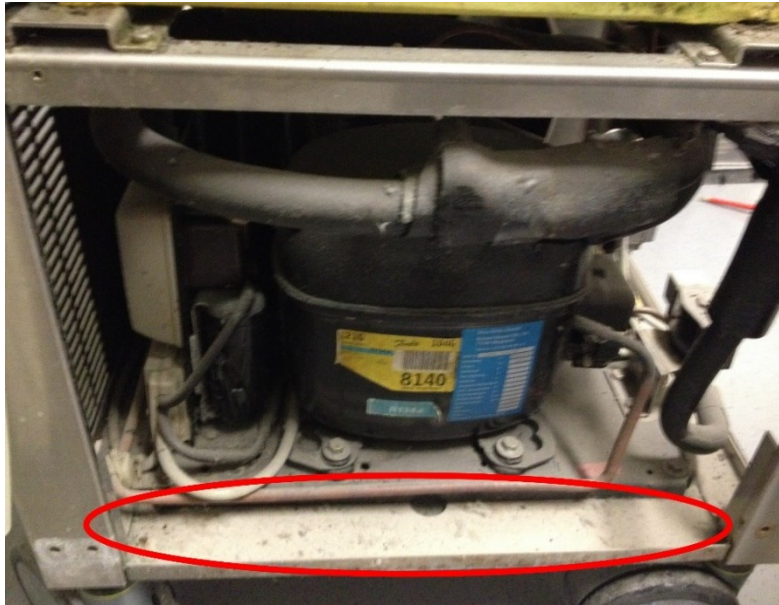
Abbildung 17: Staubbelastungen horizontaler Oberflächen innerhalb der HCU
