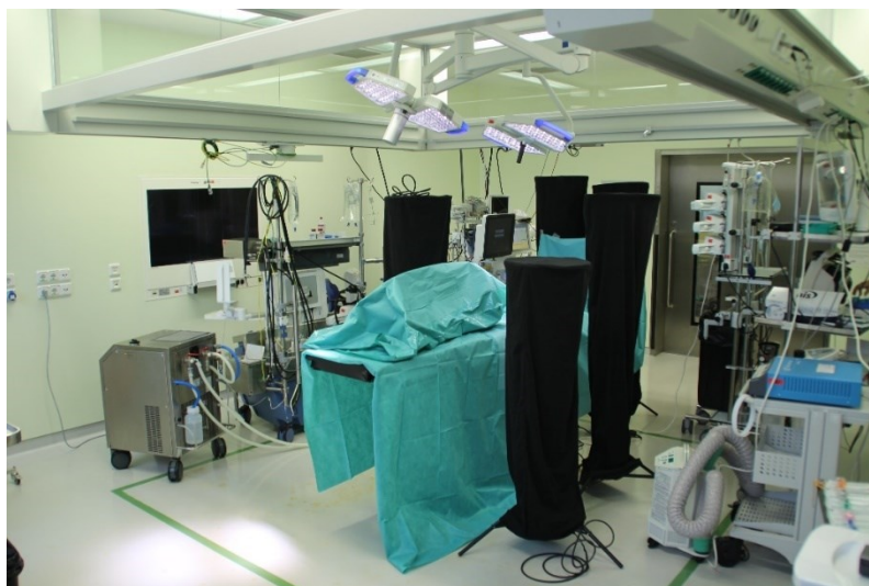
Abbildung 3: TAV-Deckensystem
