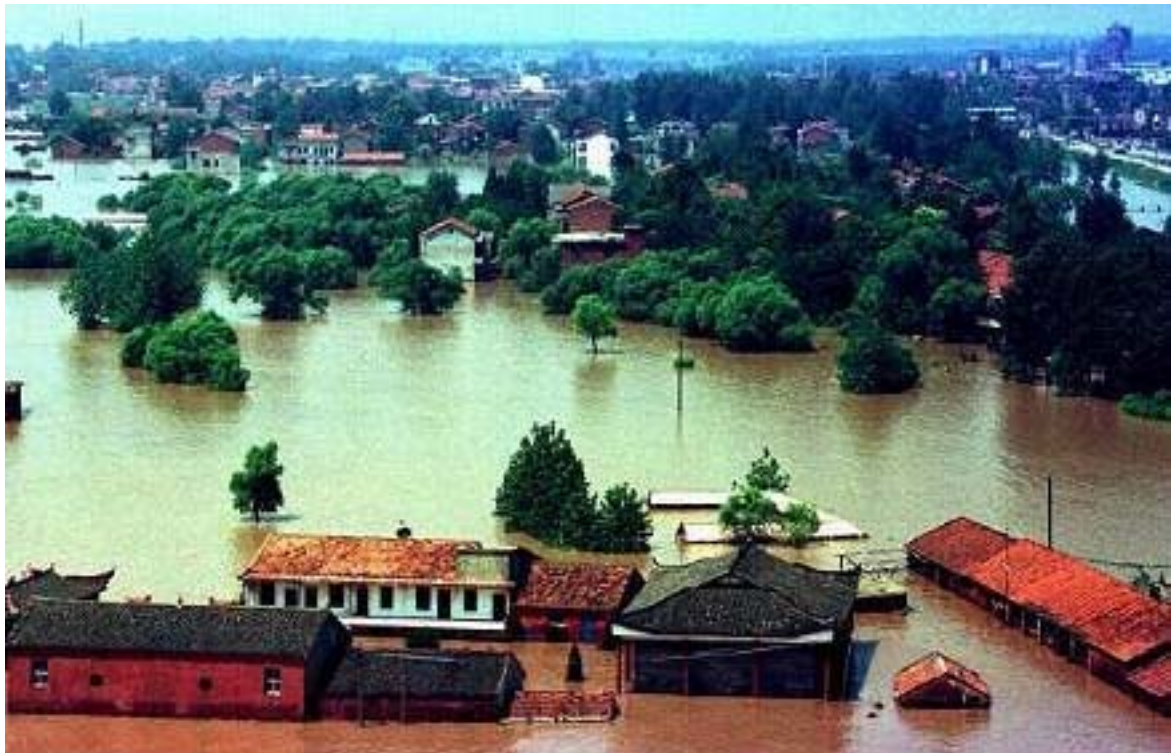
Abb. 4.11: Die Weststadt von Jiujiang nach dem Deichbruch vom 7. August 1998
