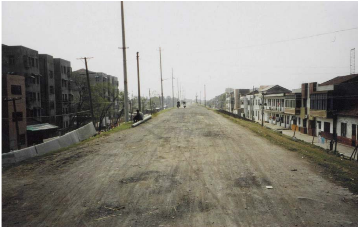
Foto 4.2: Deich zum Schutz des Gong'an Sicherheitsdistriktes im Jingjiang-Hochwasserrückhaltebecken
