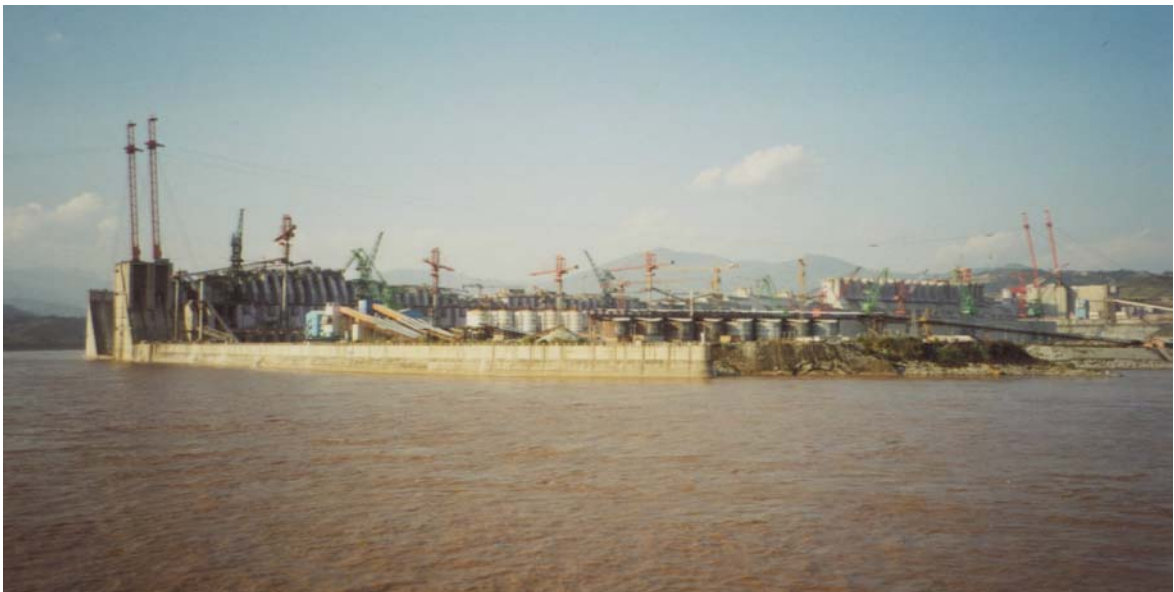
Foto 3.2: Die Baustelle des Drei-Schluchten-Projektes
