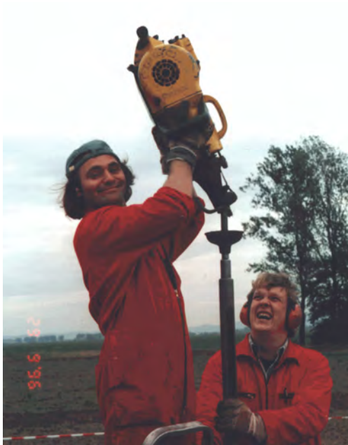
Abb. 17: Niederbringen der Bohrung mit Sonde DN 50
