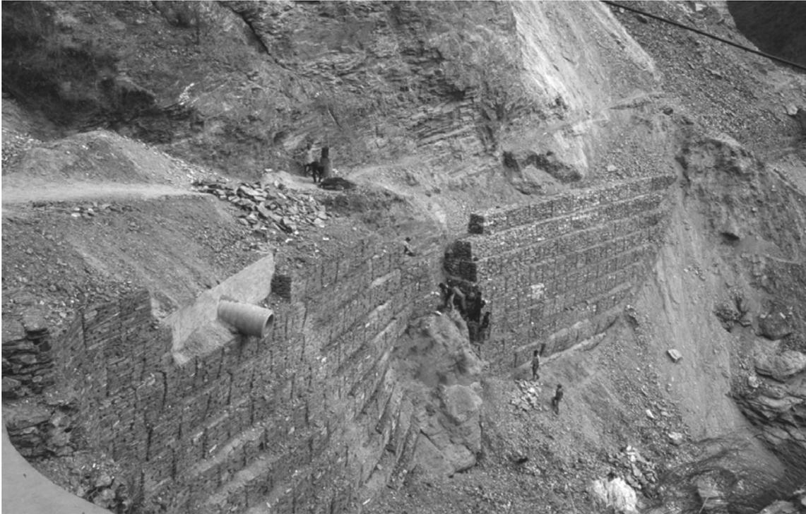
**Bild 34:** Errichtung einer Stützmauer und Drainagemaßnahmen zur Sicherung einer großflächigen Rutschung am Mayāñdi Kholā/Myāgdi Distrikt. (Aufnahme: A. Titz, März 2003)
