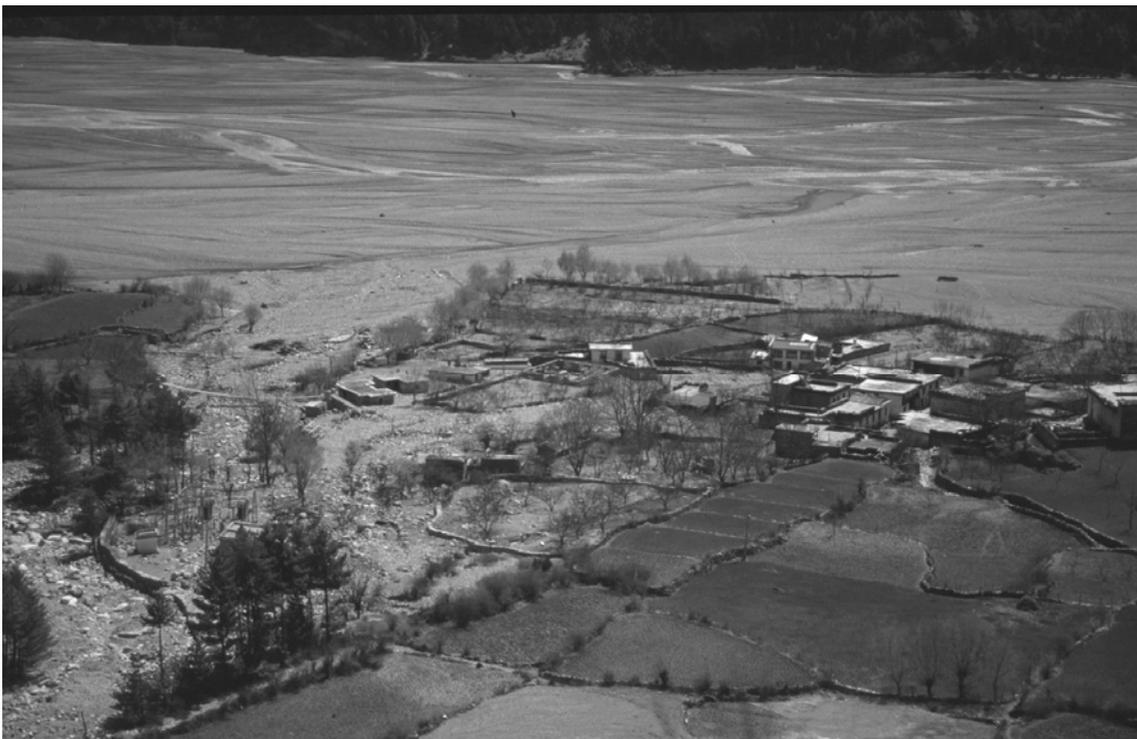
**Bild 31:** Technische Schutzmaßnahmen in Lārjuñ – am linken Bildrand Gabione, die am Ufer des Lārjuñ Kholā errichtet wurden, in der Bildmitte Buhnen und Baumpflanzungen am Ufer der Kāli Gaṇḍakī. (Aufnahme: A. Titz, März 2003)
