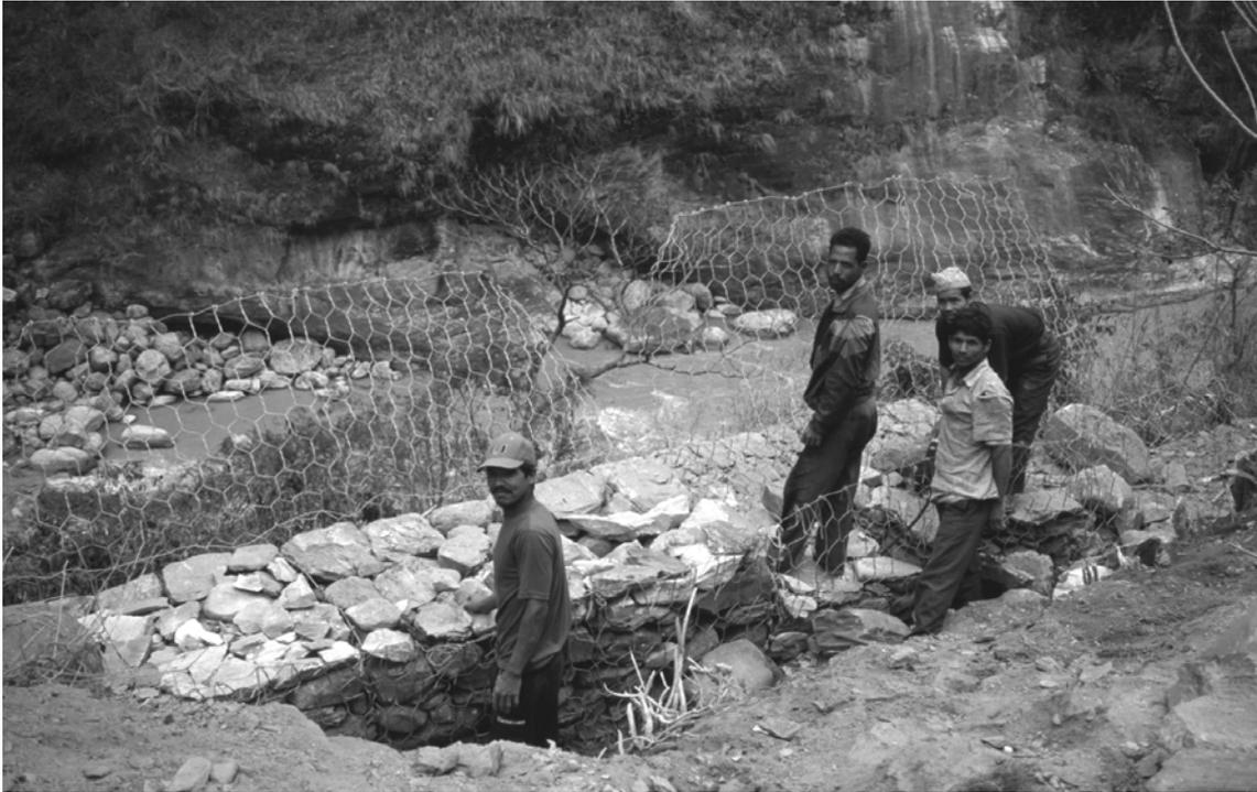
**Bild 29:** Männer befüllen im Mayāndi-Tal eine Gabion-Stützmauer mit Steinen.
