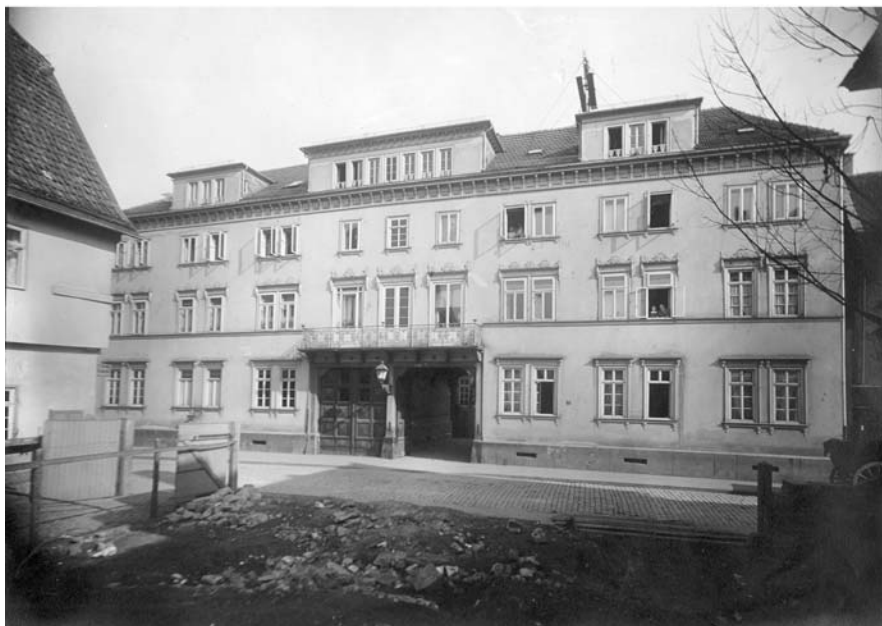
11 Fassade nach dem Umbau durch den Architekten Ferdinand Simeons.
