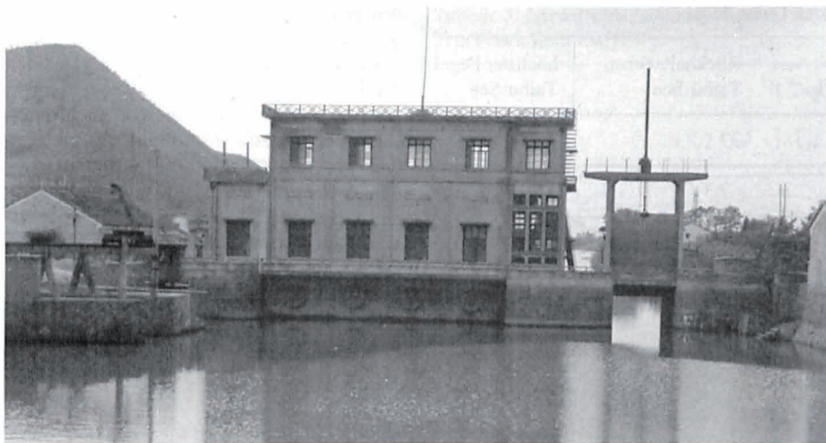
Schleuse zur Kontrolle des Zu- bzw. Abflusses des Taihu-Sees bei Hu-zhou. © Foto: Jiang Tong
