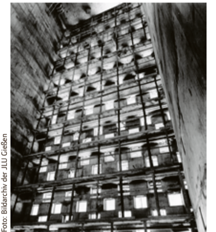
Innenansicht des Magazinturms im Bau (um 1956).
