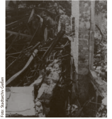
Ruine des Bücherhauses mit geschmolzenen Stahlträgern 1946.
