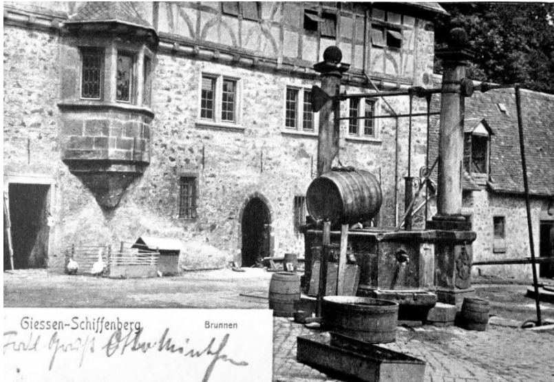
Das Foto zeigt den Brunnenauslauf und den Trog darunter, am rechten Bildrand den Zugarm, der die Wippe in Bewegung setzt.
