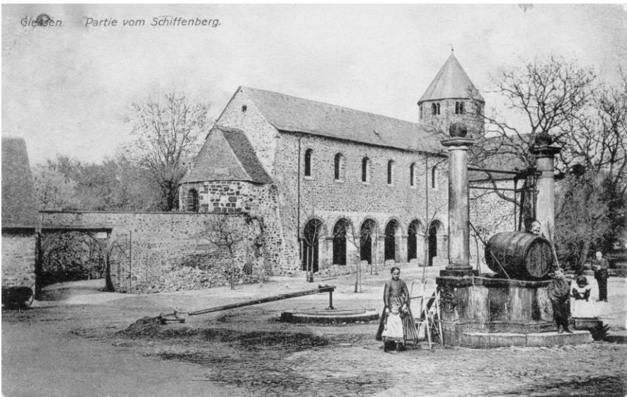
Auf der Postkarte um 1910 sind Goepel und Trense noch vorhanden, das Wasserfass liegt auf der Brunnenabdeckung. (alle histor. Abbildungen aus dem Stadtarchiv Gießen)
