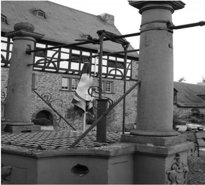
Das aktuelle Foto zeigt die Reste des Pumpgestänges, die heute noch vorhanden sind. (Foto: Kuster)
