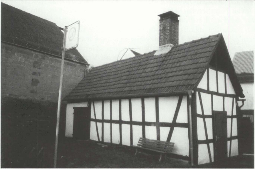
Abb. 2: Übergässer Backhaus (II) (1827) von Südwesten mit Ausgangstüre der Viehwaage (Melchior)
