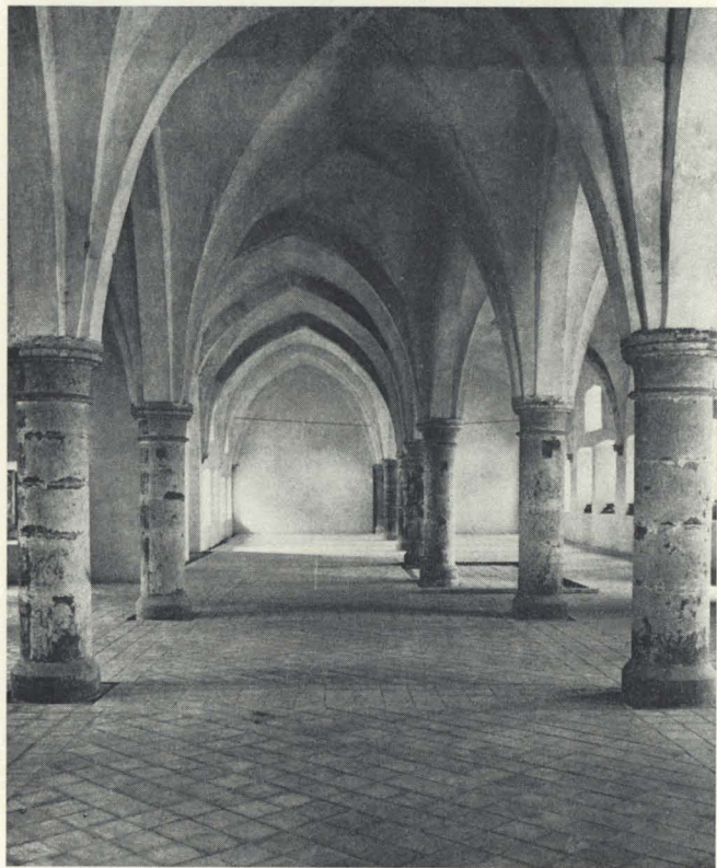
Abb. 6a: Dormitorium, Gesamtansicht von Nord.
