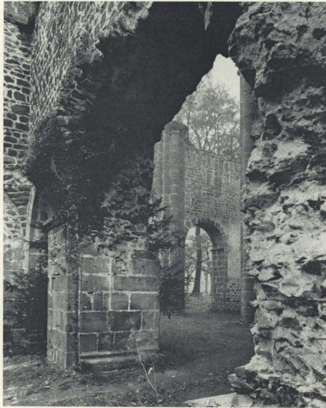
Abb. 2b: Großer Chorbogen der Klosterkirche vor der Restaurierung.
