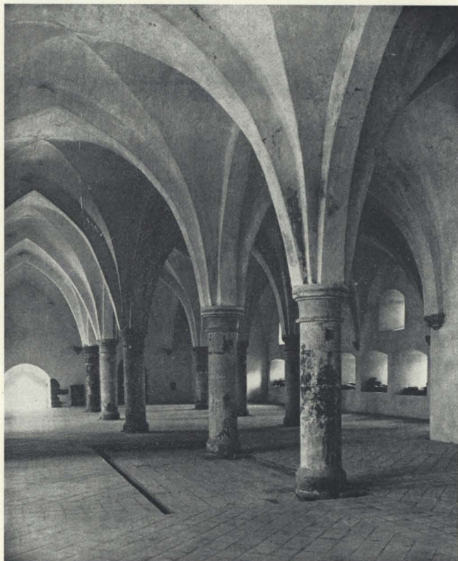
Abb. 6b: Dormitorium, Gesamtansicht von Süd.
