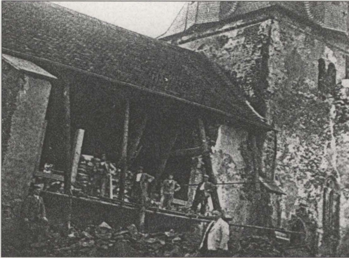
Abb. 12: Die Südseite der Kirche während der Renovierungsarbeiten 1930 (privat)
