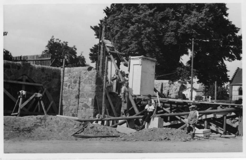
Abb. 26: Bauarbeiten am Denkmal in Wieseck (Stadtarchiv Gießen)
