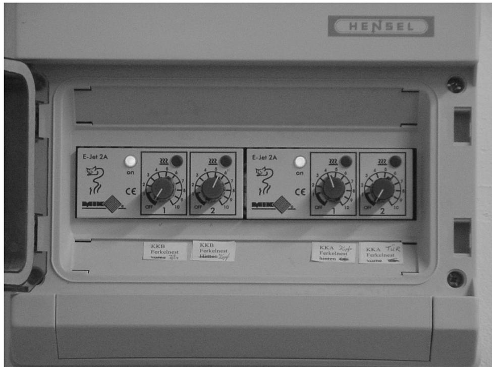
**Abbildung 4:** Regeltechnik für die Ferkelnester
