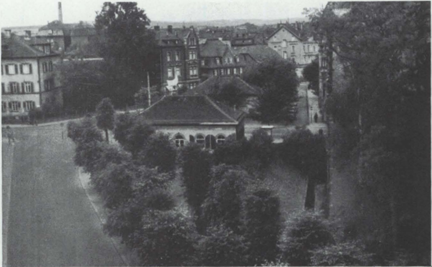
Bild 40: Selterstor vor dem Umbau in 1938; parallel zum rechten Bildrand sieht man den damals noch offenen Schoorgraben. Foto: Stadtbauamt
