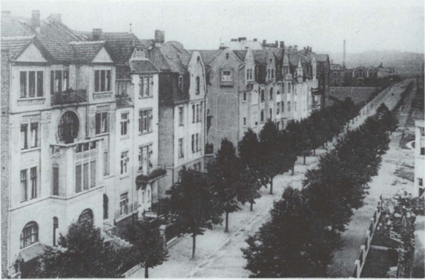
Bild 17: Private Mietwohnhäuser vor 1914 in der Liebigstraße. Im Hintergrund Werksgebäude der Fa. Heyligenstaedt & Co. Foto: R.Metzger
