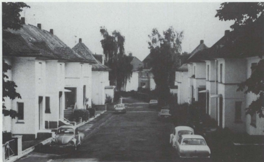
Bild 4: Carl-Vogt-Straße von der Licher Straße aus gesehen. Foto: Baugenossenschaft 1894
