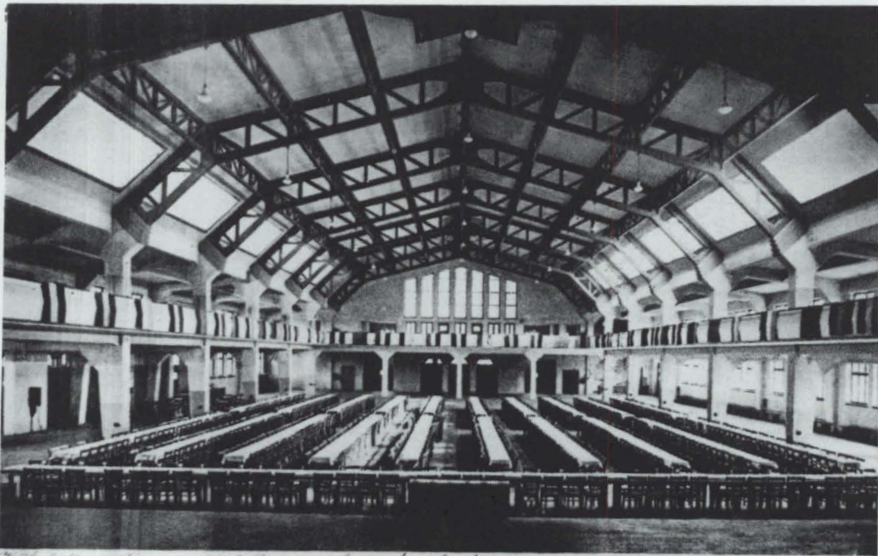
Volkshalle in Gießen, 3000 Personen faßend, erbaut 1925
