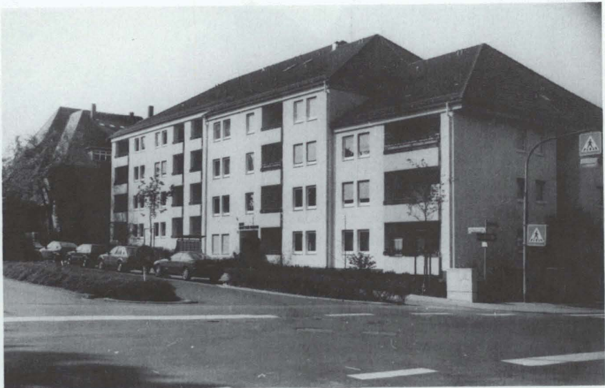
Bild 26: Altenwohnheim Curtmannstraße 38 der Heinrich-Cloos-Stiftung. Foto: R.Metzger
