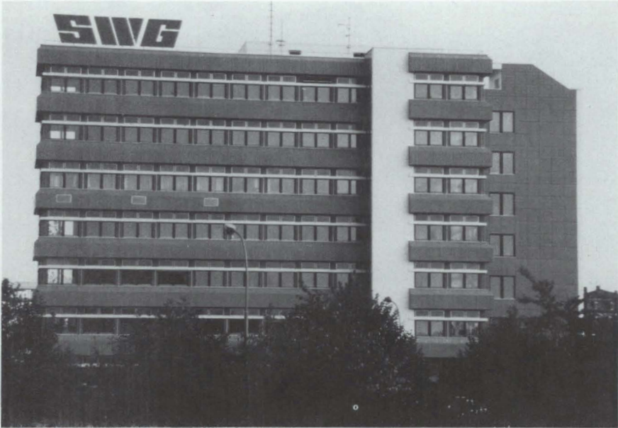
Bild 21: Stadtwerke Gießen, Verwaltungsgebäude Lahnstraße 31. Foto: von den Stadtwerken zur Verfügung gestellt
