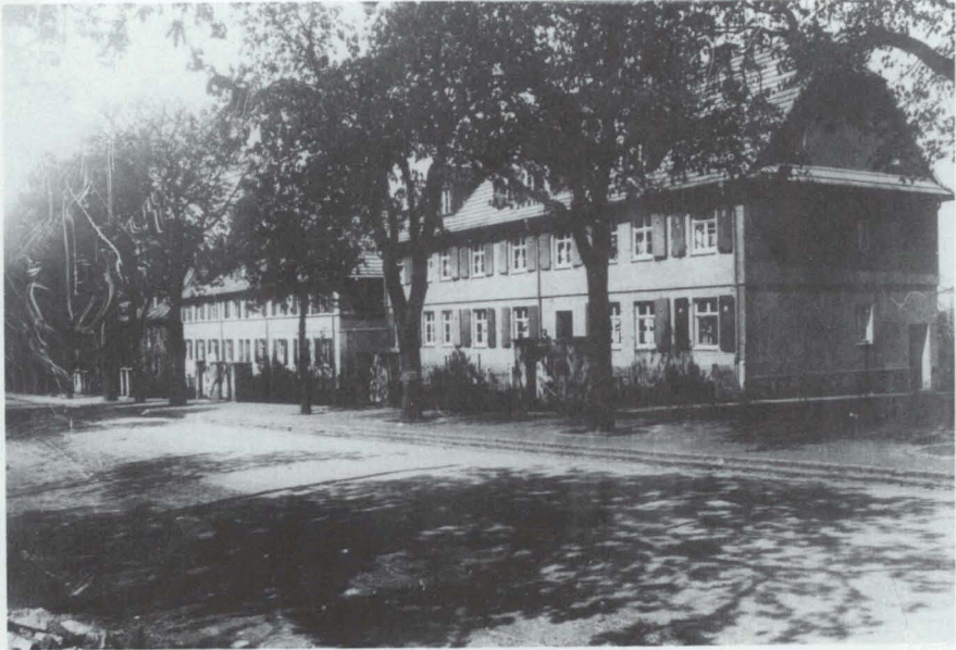
Bild 25: Städtische Wohnbauten in der Kaiserallee, erbaut 1921/22. Foto: R.Metzger
