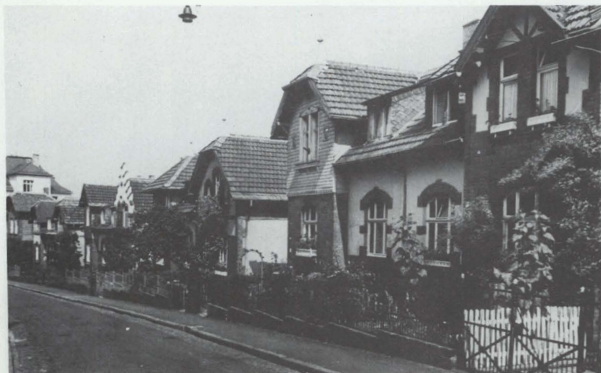
Bild 3: Blick in die Landmannstraße. Siedlungshäuser, erbaut 1896 von der "Baugenossenschaft des evangelischen Arbeitervereins zu Gießen e.G.m.b.H.". Als Ensemble unter Denkmalschutz gestellt. Foto: Baugenossenschaft 1894
