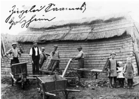
Abb. 4 – In der Ziegelei Sames wird ein Feldebrennofen gesetzt, ca. 1930. 3. von links: Georg Sames (StadtA PH, Ho 176, Repro).
