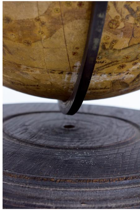
Abb. 12 Himmelsglobus, Detail des fehlenden Achsstiftes. Die Globuskugel liegt auf dem Meridianring auf. Jegliche Bewegung der Kugel verursacht Schleifspuren auf der Oberfläche der Kugel (hier weißlich).
