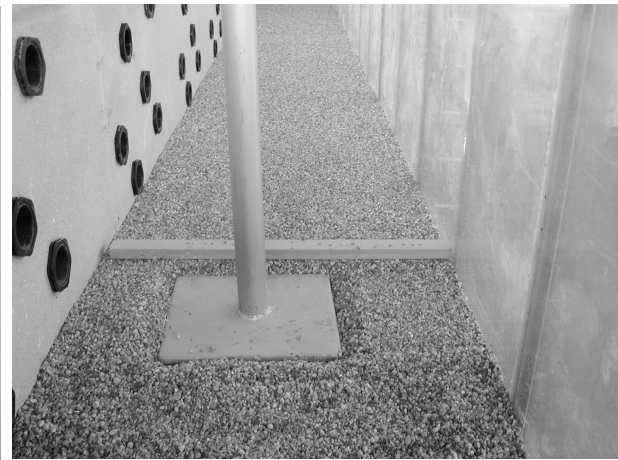
Abbildung 4.9: Verdichtung des Kapillarschichtblocks mit anschließender Begradigung
