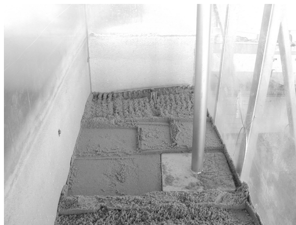
Abbildung 4.10: Kapillarschichteinbau; Verdichtung des Sandes und anschließendes Aufrauen der eingebauten Schicht
