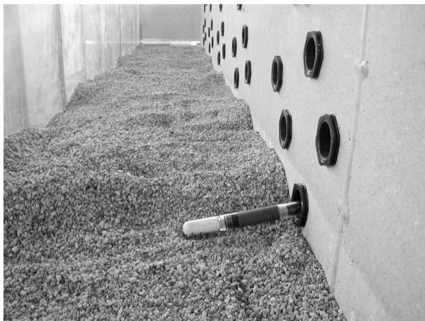
Abbildung 4.8: Kapillarschichtblock - inklusive Messgeräte-Einbau
