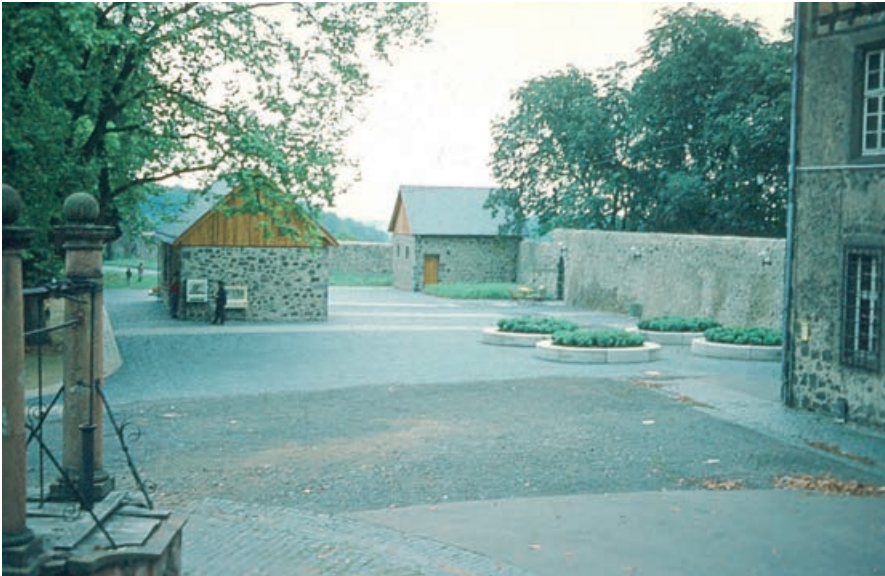
Abb. 15: Kiosk und Toilettengebäude, 1973 (Foto: Manfred Blechschmidt).
