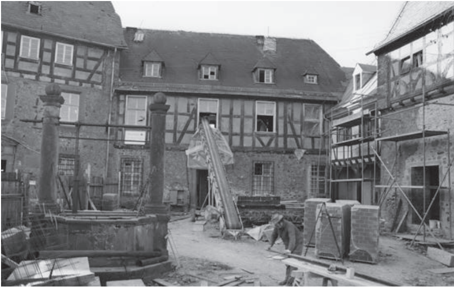
Abb. 16: Bauarbeiten an den ehemaligen Wirtschaftsgebäuden des Deutschen Ordens, Oktober 1975 (StadtA GI, 81-13909).
