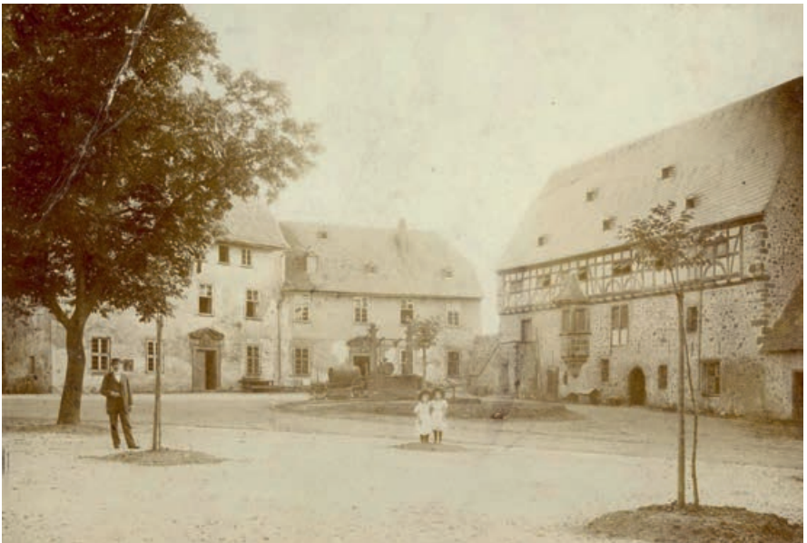
Abb. 6: Innenhof vor dem Bau des Verbindungsgebäudes, 1896 (HStAD, R 4, 19430).
