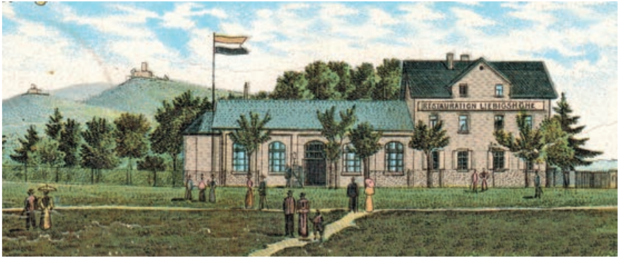
Abb. 6: Liebigshöhe im Baubestand von 1896. Links am Gebäude der chorähnliche Bühnenanbau. Ausschnitt aus Ansichtskarte, gelaufen 1897. (StadtAG, Ansichtskartensammlung W. Schmidt, Nr. 671)
