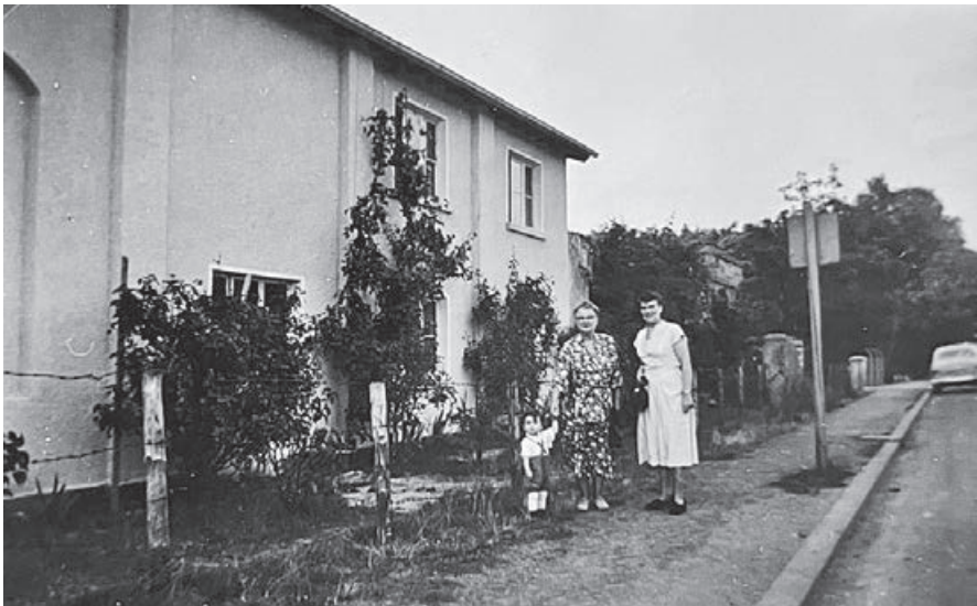
Abb. 17. Mitglieder der Familien Rätzel vor dem zweistöckigen Wohnteil an der Fröbelstraße um 1955. Links angeschnitten ist noch der gebogene Fenstersturz des ehemaligen Saals sichtbar. Rechts daneben der vermauerte erste Zugang zu dem Saal mit erkennbaren Resten der Wegbefestigung. (Privataufnahme, zur Verfügung gestellt durch Reinhard Rätzel)
