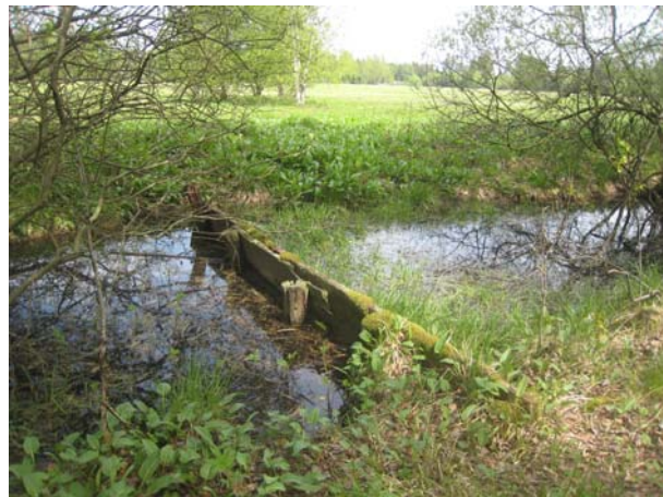
Abb. 19: Stauwehr an ehemaligem Entwässerungsgraben
