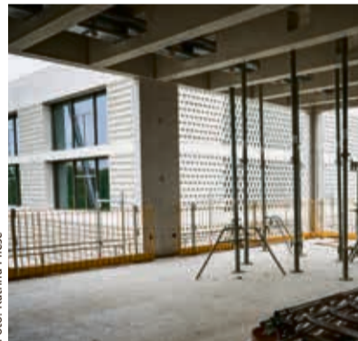
Blick aus dem Rohbau auf die neue Universitätsbibliothek.
