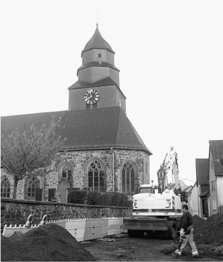
Abb. 2: Pohlheim-Grüningen. Die Stadtkirche von Süden während der Bauarbeiten (Foto: hessen.Archäologie des LfDH)
