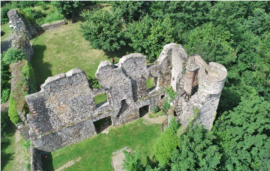
Abb. 8: Wohngebäude, Ansicht von Südosten (Juni 2021, Foto: J. Reitz).
