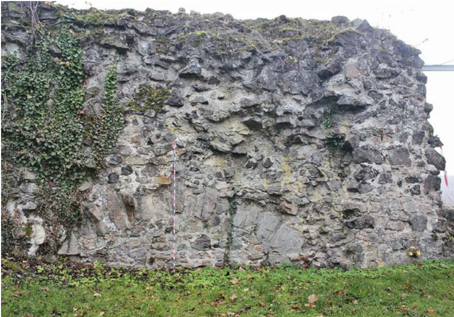
Abb. 7: Kernburg, Burghof, gemauerter Bogen in der Südmauer (Nov. 2021)
