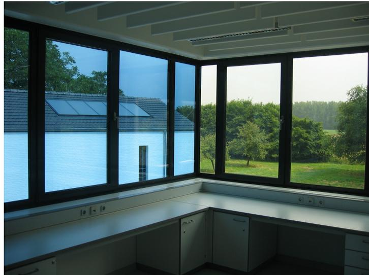
**Abbildung 1.1:** Elektrochrome Architekturverglasung im geschalteten und hellem Zustand [3]
