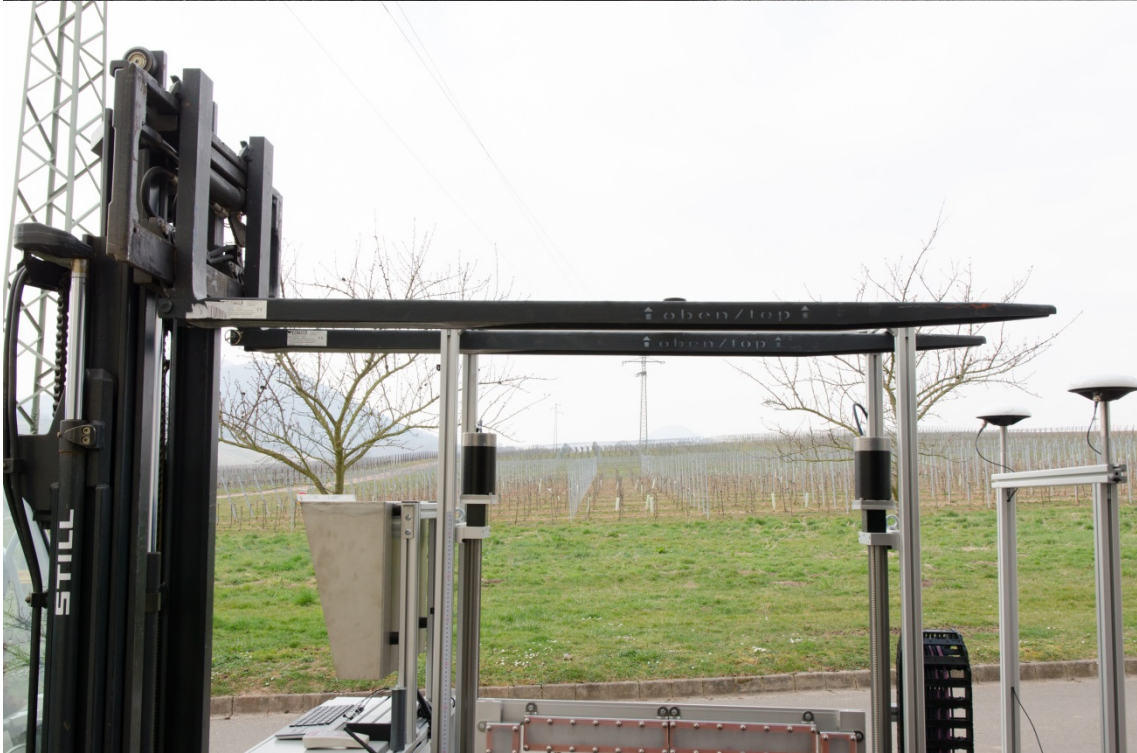
Abb. 52 Demontage des Kameralageregelungssystems; Anheben mit Gabelstapler.
