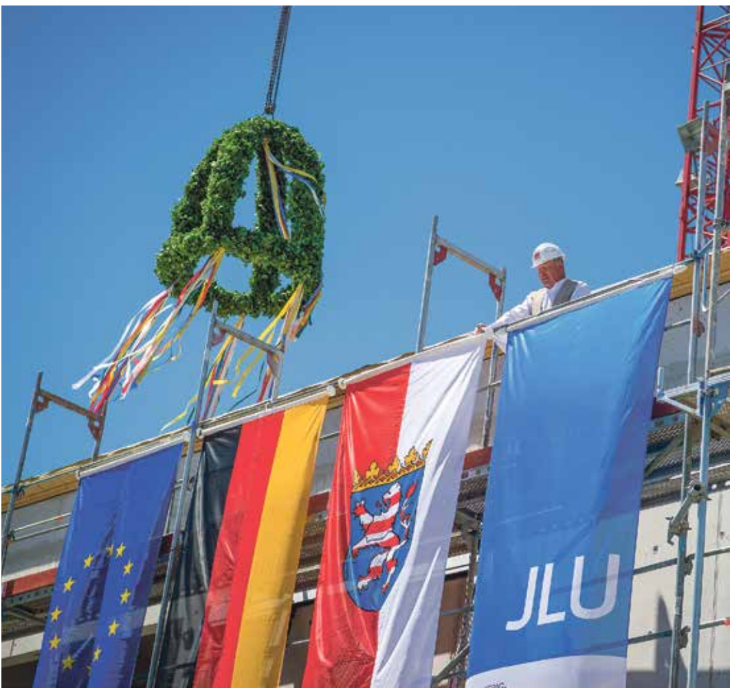
Gute alte Tradition: Polier Kuhn verliert den Richtspruch, und wenig später zerschellt ein Glas am Boden vor dem Rohbau.
