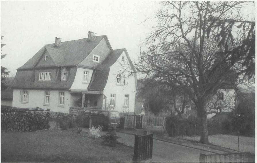
Abb. 2: Das Neue Pfarrhaus von Nordwesten
