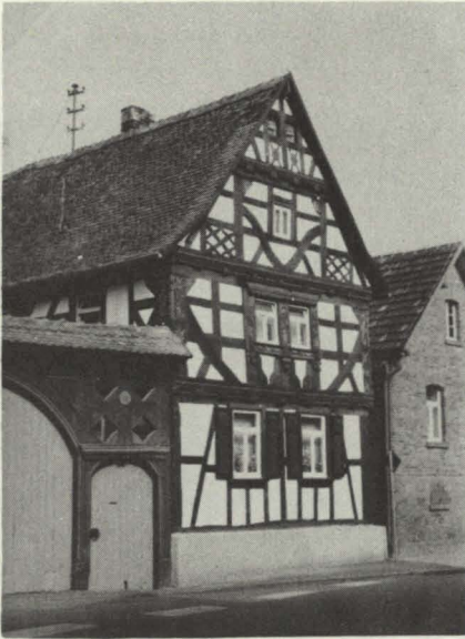
Oberhessische Holzführung, im Erdgeschoß durch schwache Hölzer erneuert, mit rheini- schen Auszierdetails
