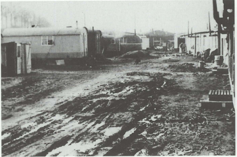
Abb. 1: Aufbau des Barackenlagers 1947-1949
