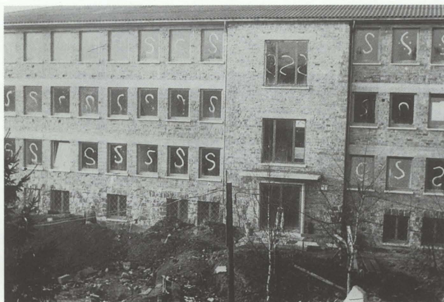
Abb. 6: Haus II, im Rohbau 1957
