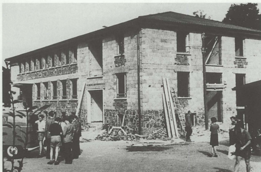
Abb. 4: Haus I, im Rohbau, (Baubeginn 1956)
