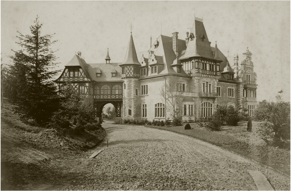
Abb. 7: Rauischholzhausen, 1878. Nordfassade des Schlosses und Fahrweg. Das Foto zeigt die gut ausgebauten Kutschfahrwege mit den noch jungen, gestaffelten Koniferenpflanzungen (Bildarchiv von Universitätsbibliothek und Universitätsarchiv Gießen, Signatur: digf00102ax).
