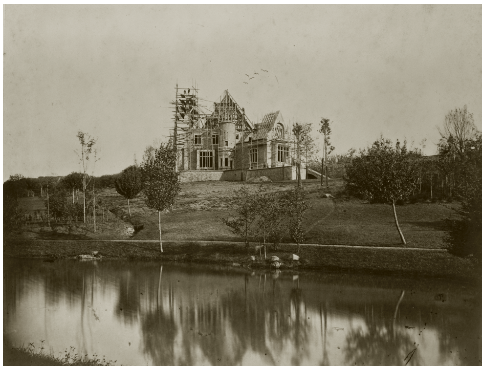
Abb. 6: Rauschholzhausen, 1874. Auf diesem Foto aus der Bauphase ist die fertig gestellte Geländemodellierung zwischen Schloss und Burgteich zu sehen. Die Baumschulgehölze und die aus dem Wald geholten Bäume lassen sich aufgrund der Kronenentwicklung gut unterscheiden (© Bildarchiv Foto Marburg/Dieter Schumacher).
