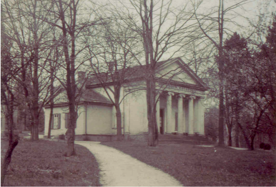
Abb. 9: Leichenhalle, zugleich Wortmann-Denkmal, auf dem Alten Friedhof (AFh) Gießen, ca.1925, Foto Untere Denkmalschutzbehörde (UDB) Gießen
