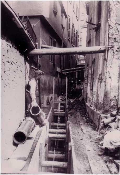
Abb. 3: Sandgasse, Kanalisationsarbeiten, Stadtarchiv Gießen, Foto- und Bildersammlung.
