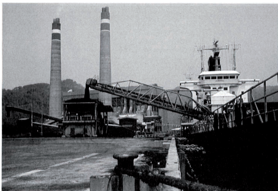
Abb. 1: Das Kohlekraftwerk von Suralaya am NW-Zipfel Javas: Solange keine Entschwefelungsanlagen eingebaut sind, zählen Kohlekraftwerke zu den Hauptemittenten von \text{SO}_2 und wichtigsten Verursachern des „sauren Regens“.
