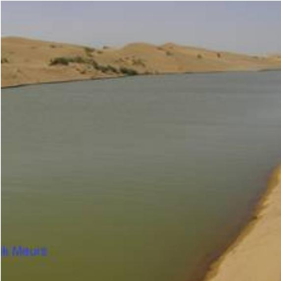
Großer Frischwasserkanal mit geringem Gefälle ohne Abdichtung im Wüstensand (Jahr der Flutung: 2014).
