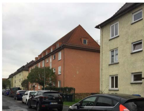
Abbildung 13: Privataufnahme, Doppelhäuser in der Werrastraße heute. Einbau von Bädern, Werrastraße 10/12, 1975.
