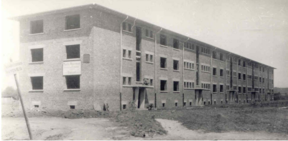
Abbildung 2: StdtAG, Rohbauten im Asterweg 1930
