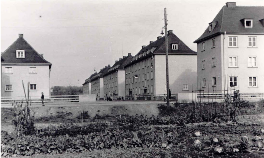
Abbildung 7: StdtAG, Bericht über sämtliche Bauvorhaben in Gießen zwischen 1933 und 1936, Gießener Anzeiger vom 29./30.04.1939
