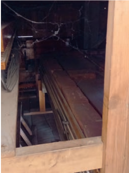
Abb. 8 a und b: Original aus der Erbauungszeit (1905) erhalten sind das doppelfaltige Magazin mit Schöpfbälgen im Inneren des Orgelfußes (links) und die Tretanlage (rechts).
