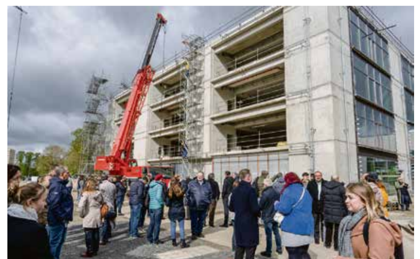
»Herzstück«: Seit der viergeschossige Rohbau der Zentralbibliothek fertiggestellt ist, wird der »Campus der Zukunft« am Philosophikum immer deutlicher sichtbar.
