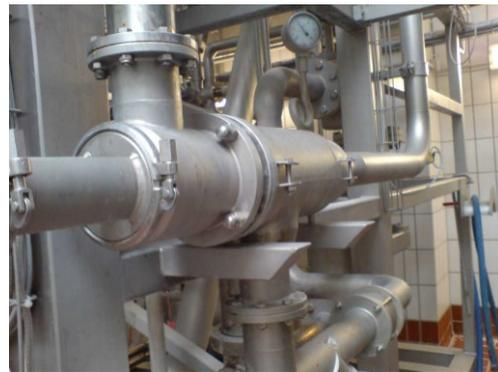
Abb.: 3.2.16: Rohmilchkühler (links) und Dampfinjektor (rechts) in Molkerei M4
