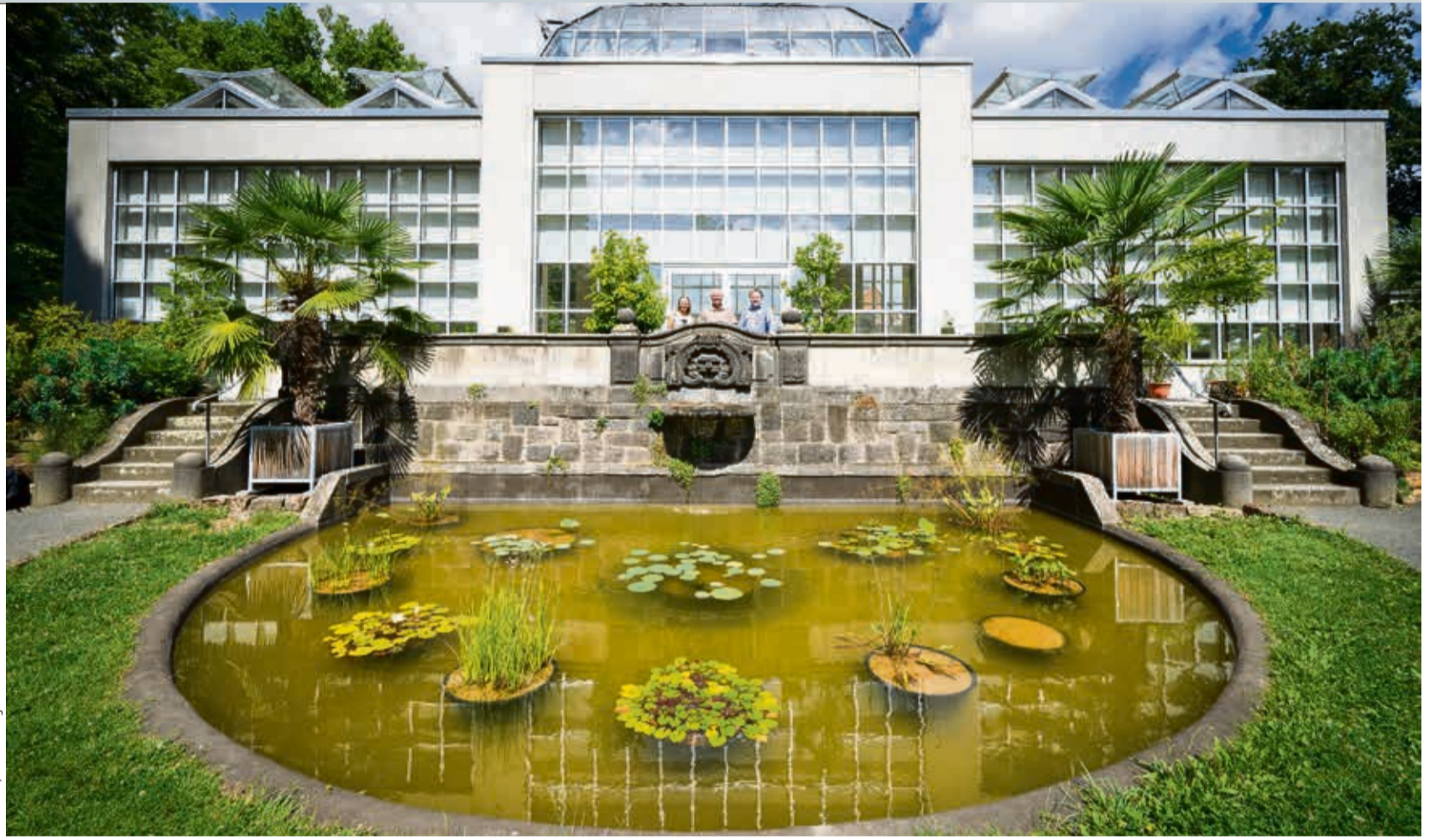
Blickfang: Der Löwenbrunnen im Botanischen Garten wurde saniert und neu bepflanzt. Groß war die Freude nach Abschluss der Arbeiten bei allen Beteiligten, darunter Christin Wysotzki, Dezernat Bau und Technik der JLU, Holger Laake, Technischer Leiter, und Prof. Volker Wissemann, Wissenschaftlicher Leiter des Botanischen Gartens (v.l.).
