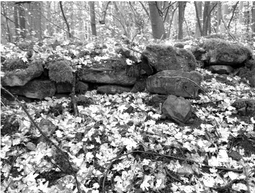
Abb. 2: Bruchsteinversturzung im nördlichen Wallbereich am Totenberg mutmaßlich mit Resten einer äußeren Mauerschale (Foto: vb)
