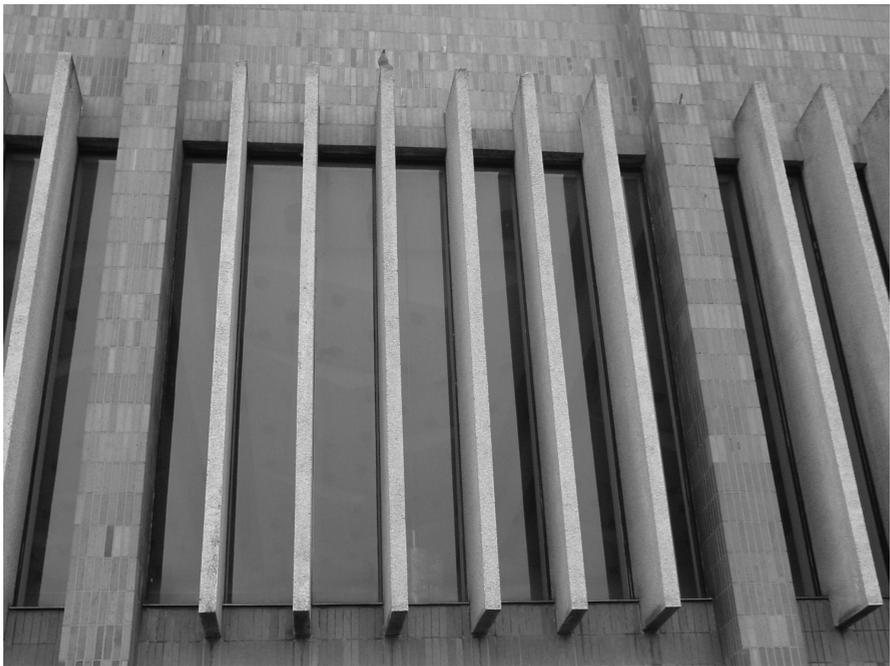
*Bild 9: Kongresshalle Gießen - Nahaufnahme der Stützpfeiler mit Sonnenblenden (Foto Budzynski 2009).*
