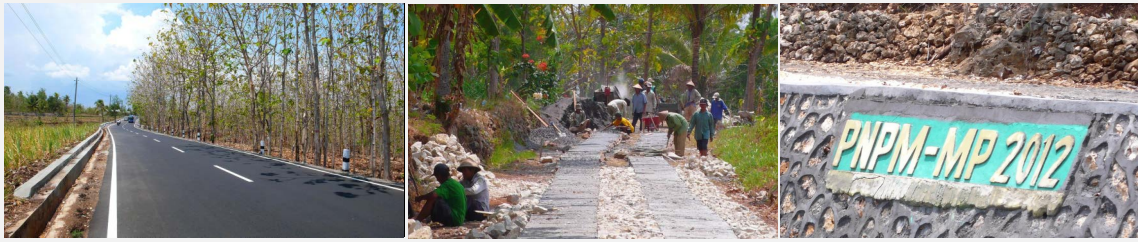
Abb. 59: Straßenbau in Gunungkidul (EIGENE AUFNAHMEN 2011 und 2012). Die Abbildungen zeigen von links nach rechts: Von DPU errichtete Hauptverbindungsstraße auf dem Wonosari-Plateau, lokale Bevölkerung beim Bau einer Dorfstraße im Rahmen des PNPM-Programmes, durch PNPM Mandiri fertiggestellte Dorfverbindungsstraße. Vor allem in den Höhenlagen lassen sich weiterhin schlechte und kaputte Straßen finden.
