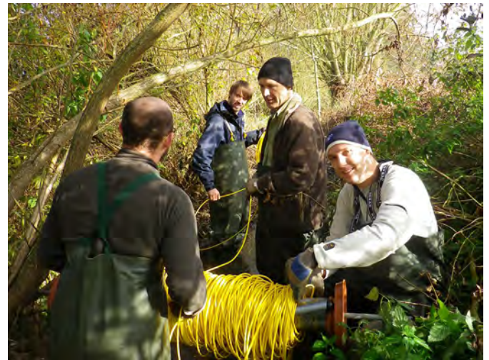
Mitarbeiter der Professur für Ressourcenmanagement beim Verlegen des Glasfaserkabels im Schwingbachtal
