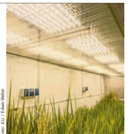
Sparsamer: LED-Lichtdecken reduzieren den Energieverbrauch und sorgen durch geringe Abwärme zugleich dafür, dass die Klimakammern weniger gekühlt werden müssen.
