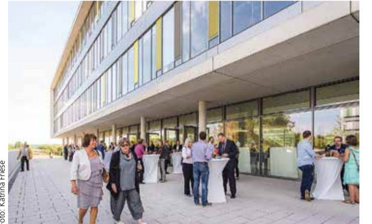
Das Instituts- und Hörsaalgebäude Chemie besticht durch seine klaren Strukturen und die ansprechende Optik.
